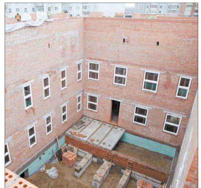
Строители приступили к установке оконных блоков и монтажу навесного фасада
