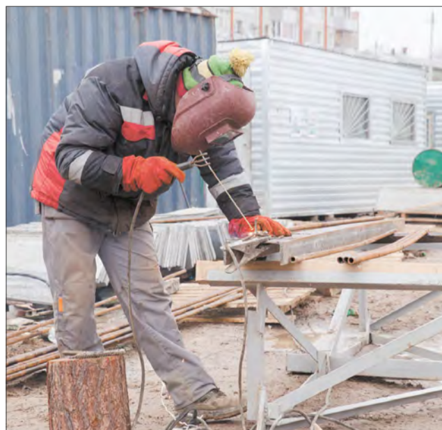
В здании смонтирована система отопления, проложены сети канализации и наружные теплосети
